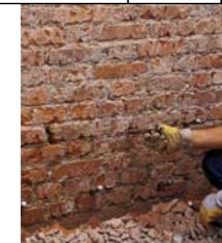
Вставляем инжекторы в отверстия
