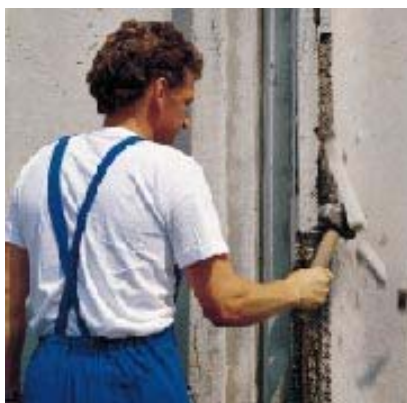
удаление разрушенного бетона
