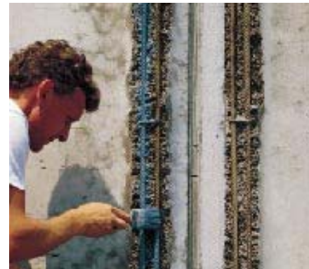
нанесение MAPEFER 1K
