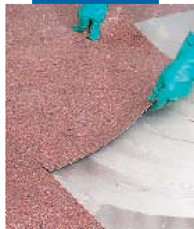
Монтаж ПВХ с помощью Adesilex G19
