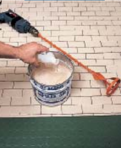
Adesilex G19: смешивание двух компонентов
