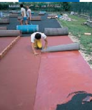
Монтаж Sportflex Super X с помощью Adesilex G19
