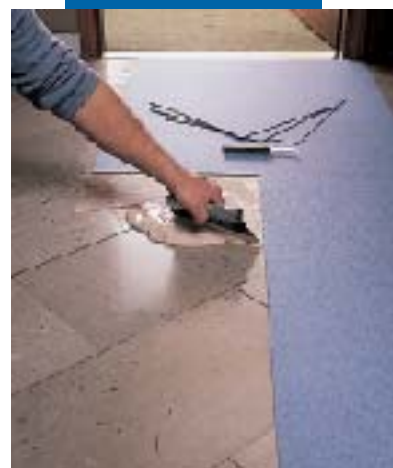
Монтаж ПВХ на непористую основу с помощью Adesilex G19
