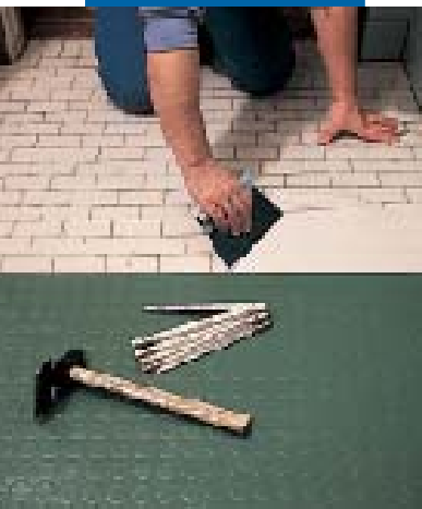
Размазывание Adesilex G19 с помощью фигурной затирки
